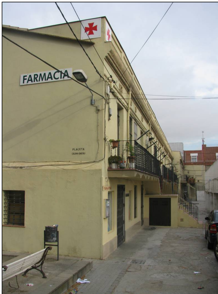
Vista general del carrer Colònia Bausili
